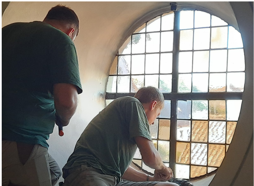
„Die beiden Monteure beim Einsetzen der Scheiben“
